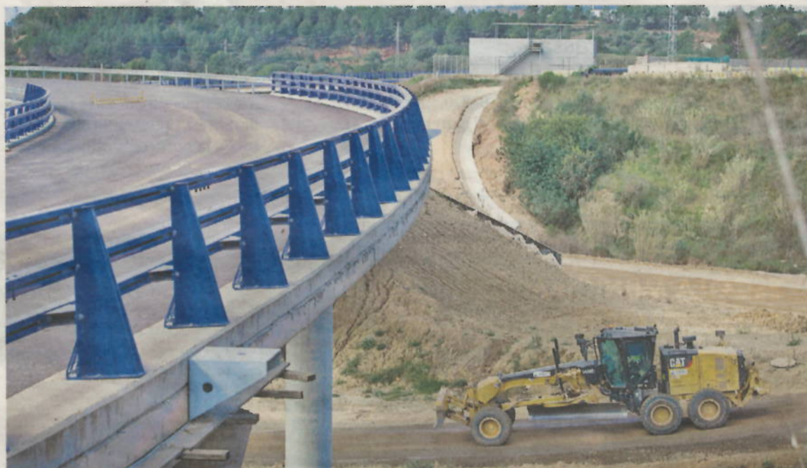
Les obres del IV Cinturó van a un pas molt lent i no se sap quan acabarà el tram Viladecavalls-Olesa. N.A.
